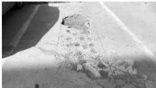
小区道路上留下风镐钻孔
