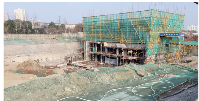
越城天地项目工地现场
