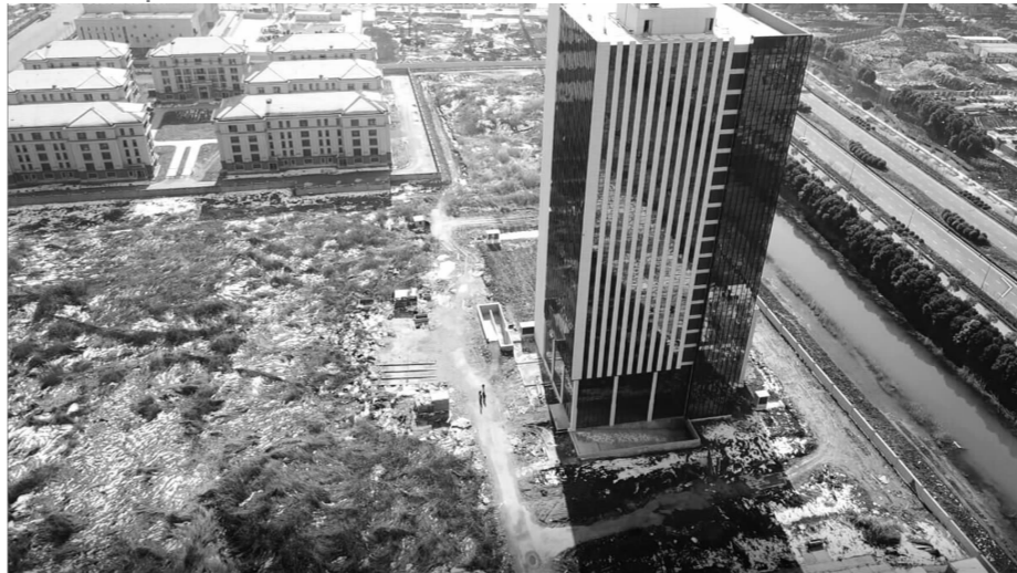
“江北智慧城”项目现场荒草遍地
