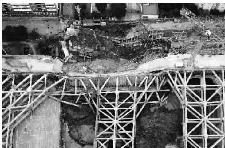
航拍塌陷现场
