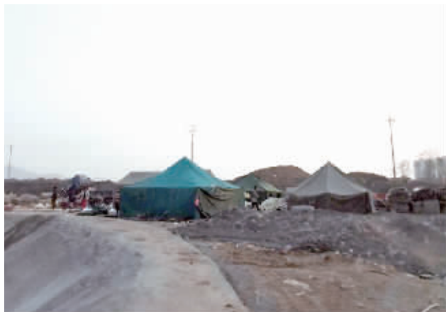
项目二期地块施工队已进场,搭起几座简陋帐篷
