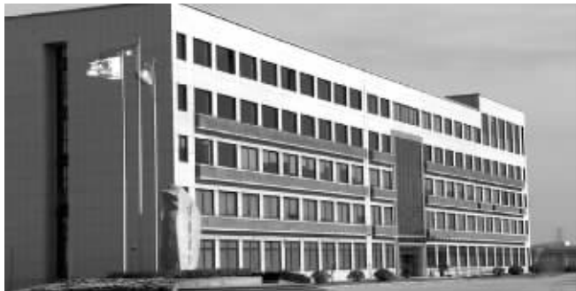
莎普爱思工厂内的质检和科研大楼 新华社记者 李涛 摄
