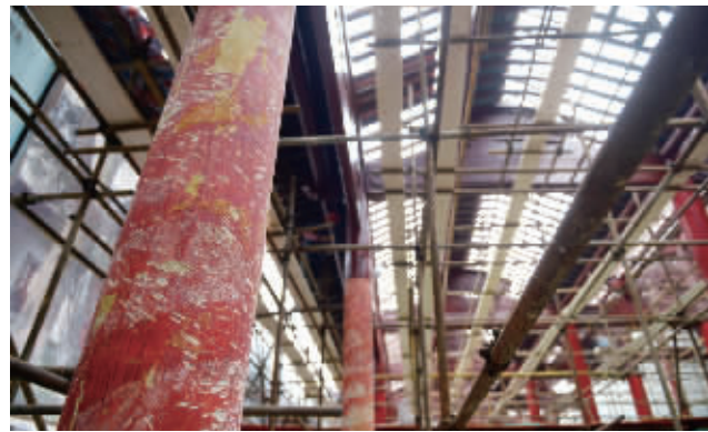
总统府大堂已搭起脚手架,正式开始修缮
