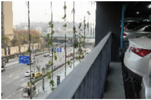
立体停车库外墙是镂空的
