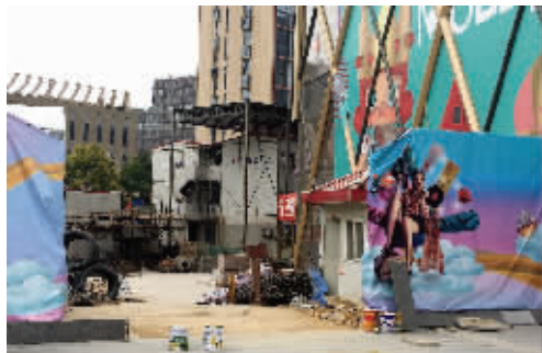
商场外部还在施工
