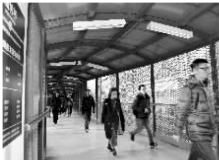
油坊桥站换乘通道是镂空造型的网状防护结构
