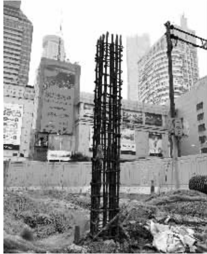
新的洪武路天桥开建
