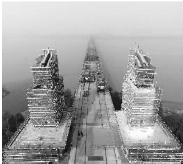
南京长江大桥封闭1周年,维修工程进度已过半
