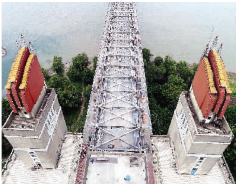
长江大桥正桥的混凝土面板已经全部拆除 现代快报/ZAKER南京记者 顾炜 摄
