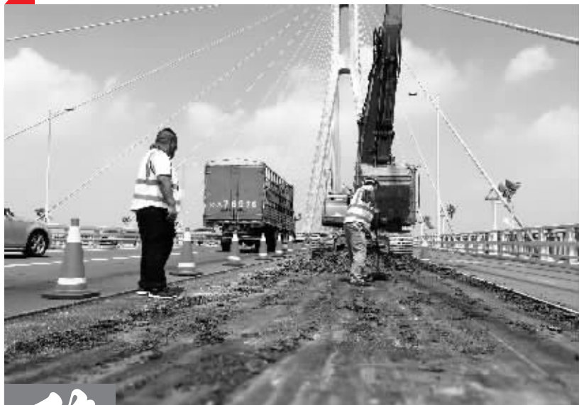
南京长江二桥部分路段封闭施工现场 交警供图
