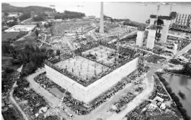
相当于4艘辽宁舰总吨位的沉井
