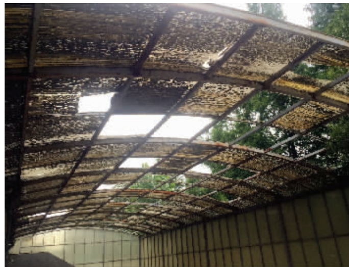
中国人家小区的地下车库入户棚
