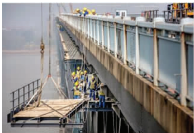
南京长江大桥维修,工人正在吊装外棚架钢结构
