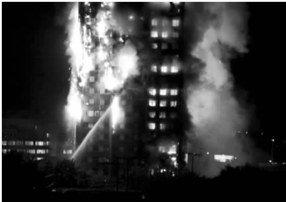
当地时间14日凌晨,伦敦西部一栋27层的公寓大楼发生大火,火势猛烈,几乎蔓延到了所有楼层。约200名消防员和40辆消防车前往灭火
