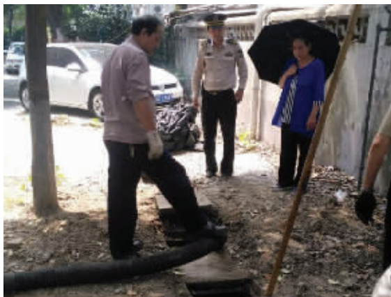
城管队员和社区人员一起疏通下水道 梁溪城管供图
