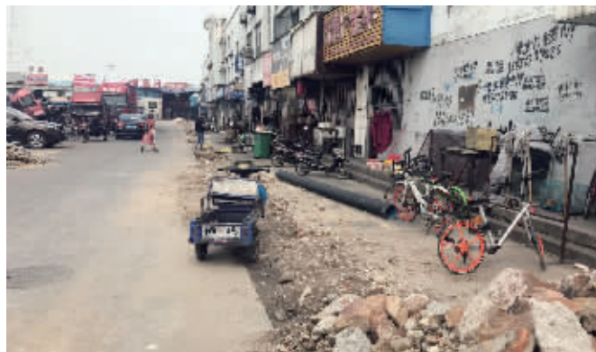
停车场内正在排布管线
