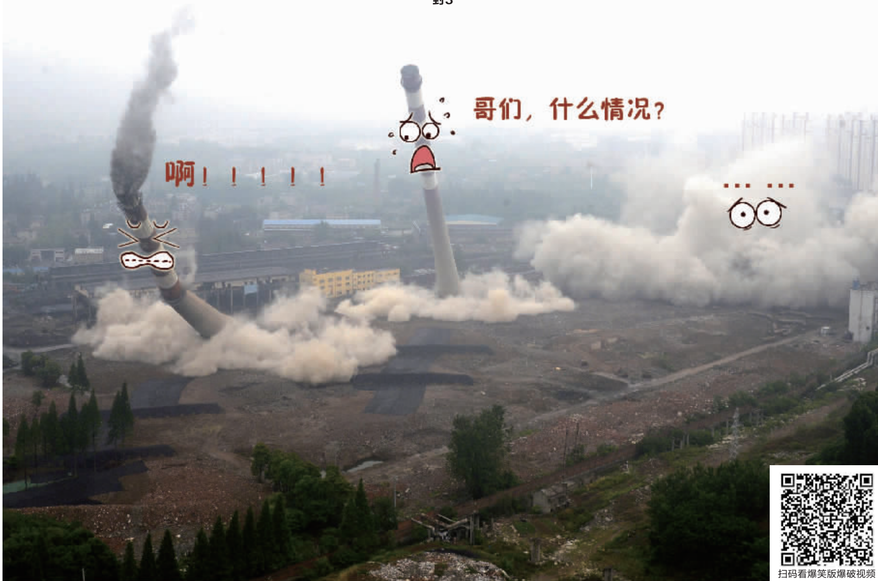
5月23日下午，位于南京第二热电厂内的两座烟囱和一座冷却塔爆破倒地 现代快报/ZAKER南京记者 赵杰 顾炜 马晶晶 吉星 摄 制图 俞晓翔
