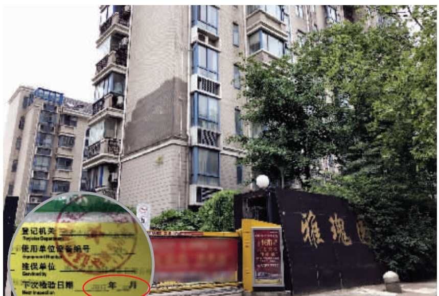
雅瑰园小区13部电梯超期未检 现代快报/ZAKER南京记者 虞健熙 摄
