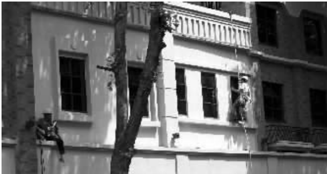
5月14日,两位工人在为太平南路上的一处建筑外墙施工 CFP供图
