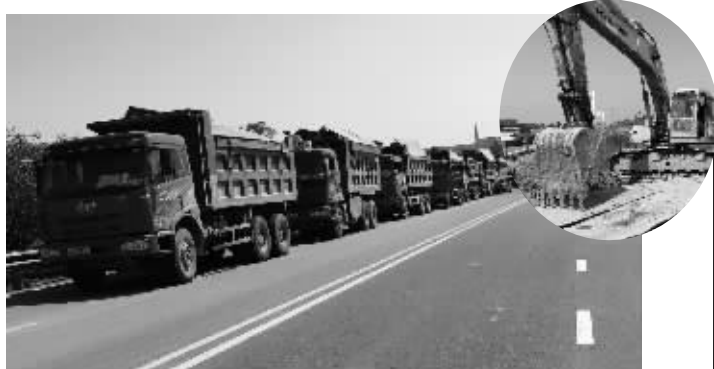
渣土车排队停靠在路边准备倾倒渣土,小图为正在作业的挖掘机 相董供图
