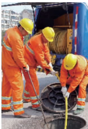
疏通堵塞管道
