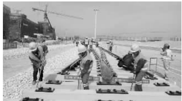
地铁1号线开始铺轨 沈琳 摄
