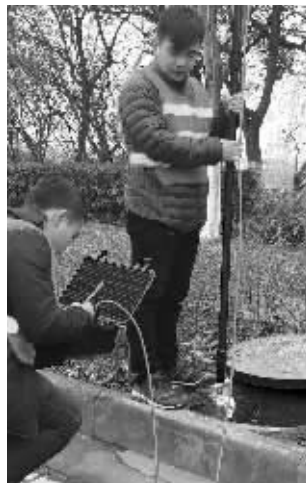
工作人员在用“管道内窥镜”检查雨水管道 滨湖城管供图
