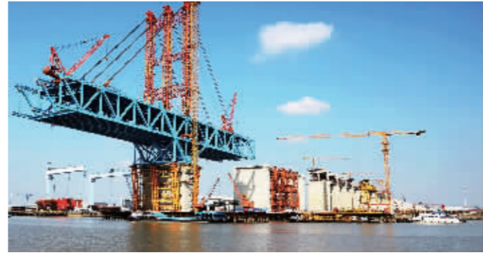
建设中的沪宁铁路长江大桥 本版均为通讯员供图
