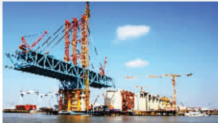
建设中的沪通铁路长江大桥
