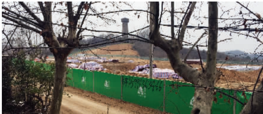
2月7日记者现场采访时,远洋山水一期项目已停工
