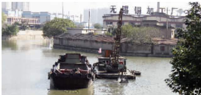
曹王泾河清淤现场 本版图片由滨湖区水利局提供
