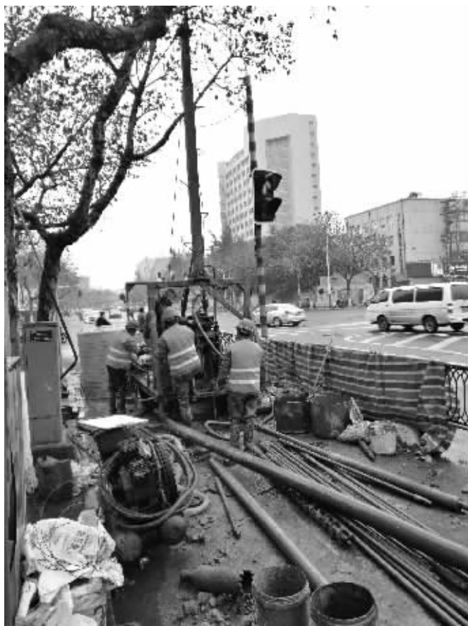
地铁7号线福建路勘测现场
