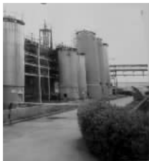
德司达公司罐区
