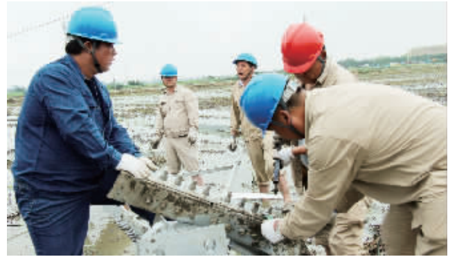
该公司员工在盐城风灾现场抢修受损铁塔
