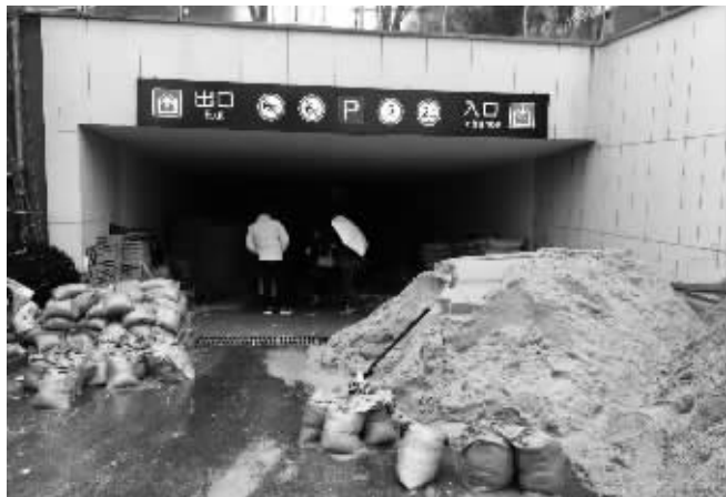
“指定商家”把建筑材料堆放在地下车库出入口
