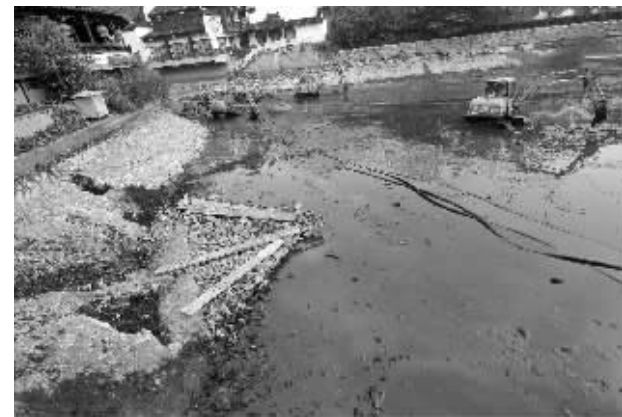
夫子庙洋池正在清淤施工 现代快报/ZAKER南京记者 施向辉 摄
