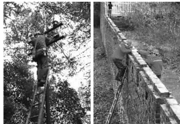
路灯维修工人在检修 现代快报/ZAKER南京见习记者 赵冉 摄
