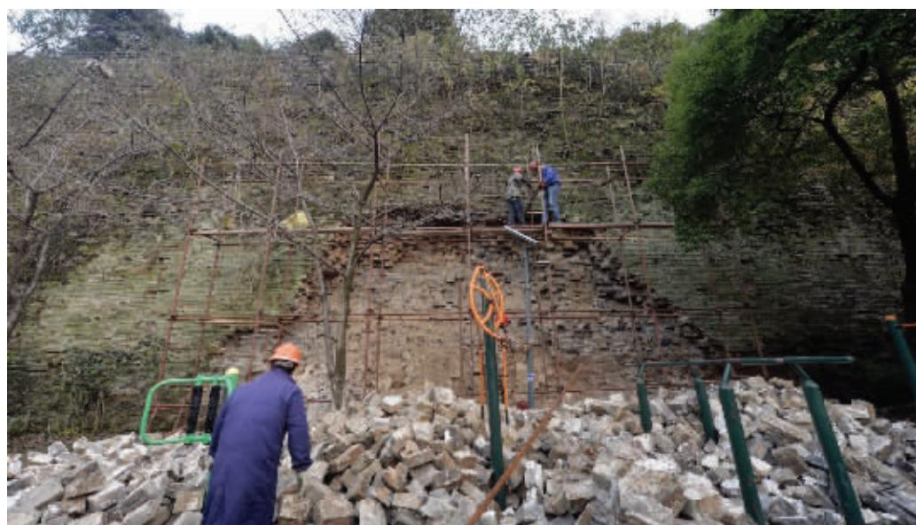
南京明城墙小桃园段局部坍塌,工作人员正在搭脚手架准备维修 现代快报/ZAKER南京记者 赵杰 摄
