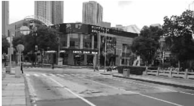
改造前的西瀛里 市建设局供图
