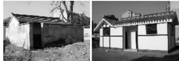
长江路观滁村38号旱厕改造前后对比 市城管局供图
