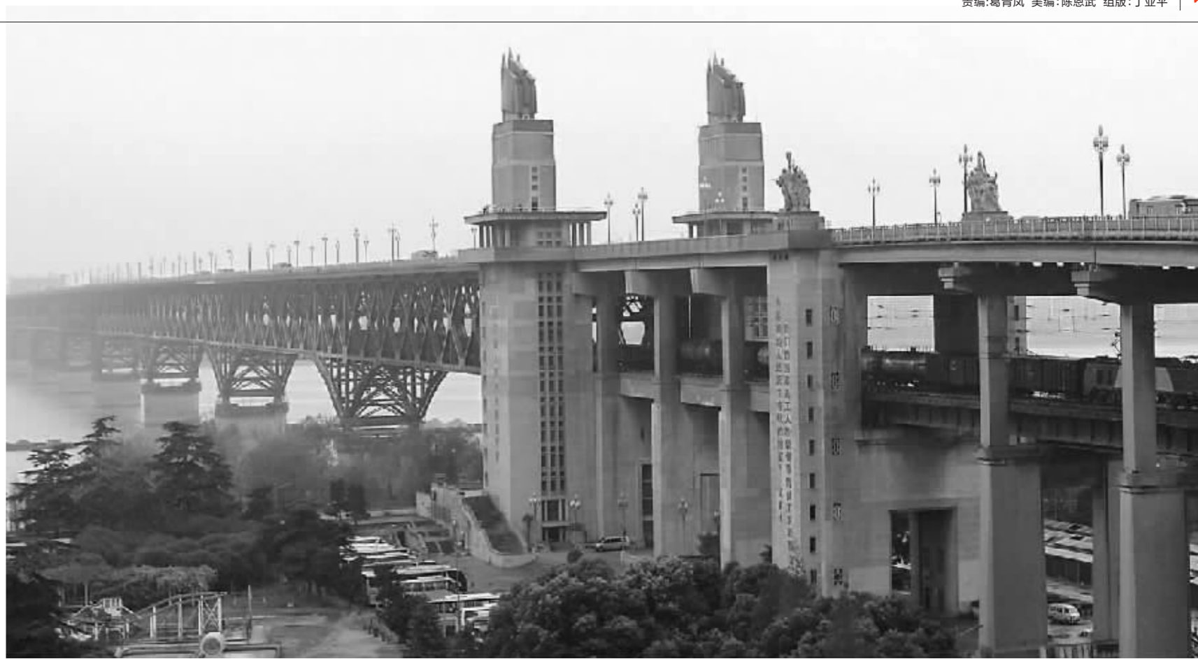
即将封闭大修南京长江大桥
