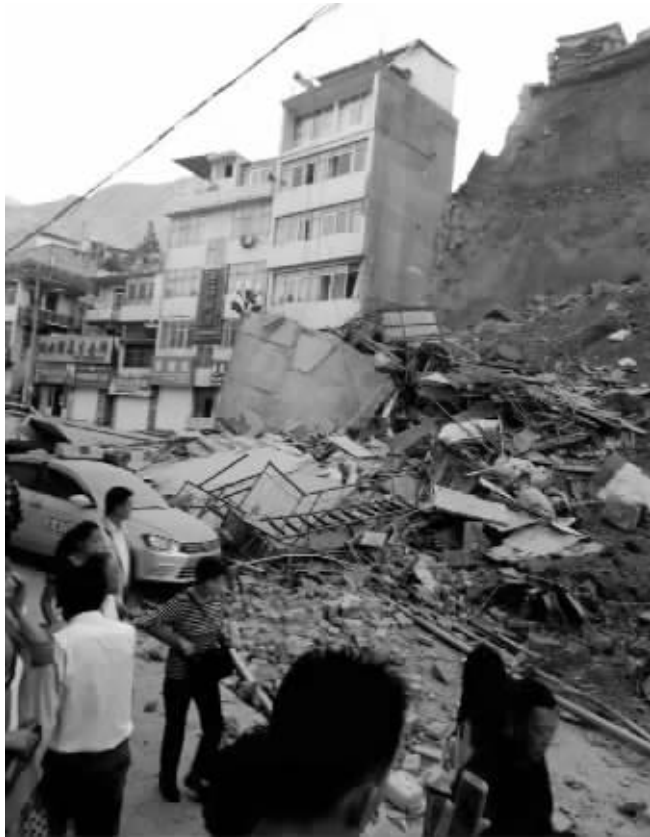
居民自建房屋被埋
