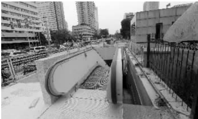
江苏考试院旁的一号口,雨棚被拆
