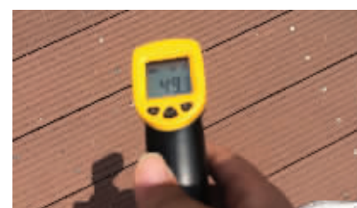
屋顶裸露地面温度49.3℃
