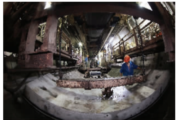
施工人员在盾构机中施工 现代快报/ZAKER南京记者 顾炜 摄
