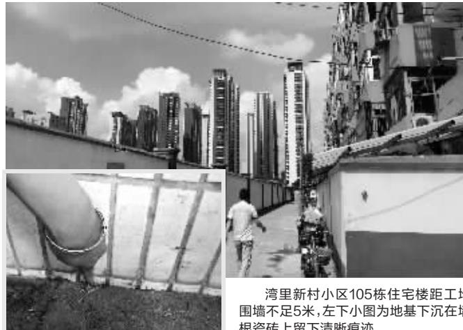
湾里新村小区105栋住宅楼距工地围墙不足5米，左下小图为地基下沉在墙根瓷砖上留下清晰痕迹
