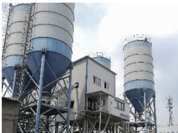
无证搅拌站的生产装置
