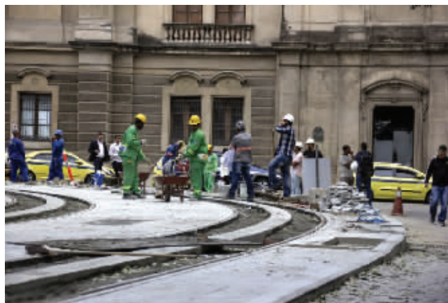
里约热内卢，工人们正在赶修奥林匹克大道
