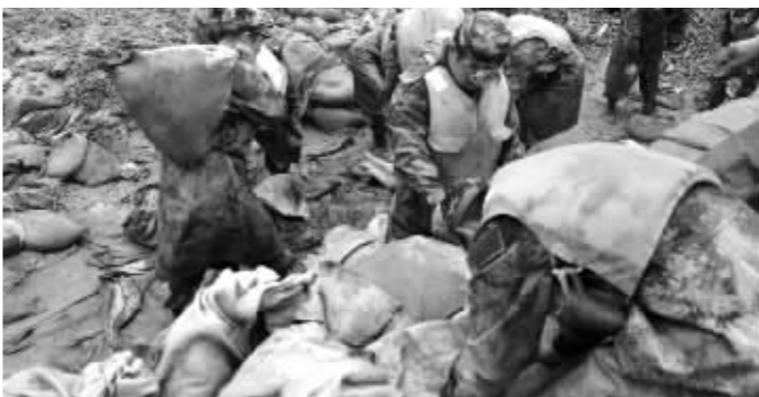
战士们在长江主堤的背水侧构筑子堤
