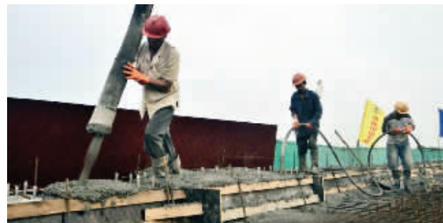
工人在浇筑最后一车混凝土 网络图片(请作者联系我们领稿费)
