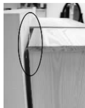
抽屉柜与墙壁之间的固定装置
